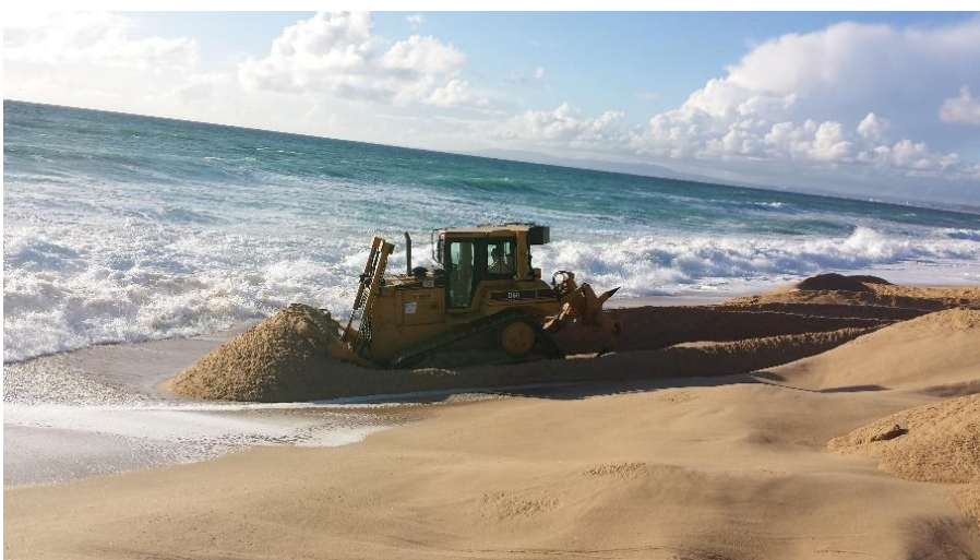
Fotografia 3 – Operações de abertura da barra
