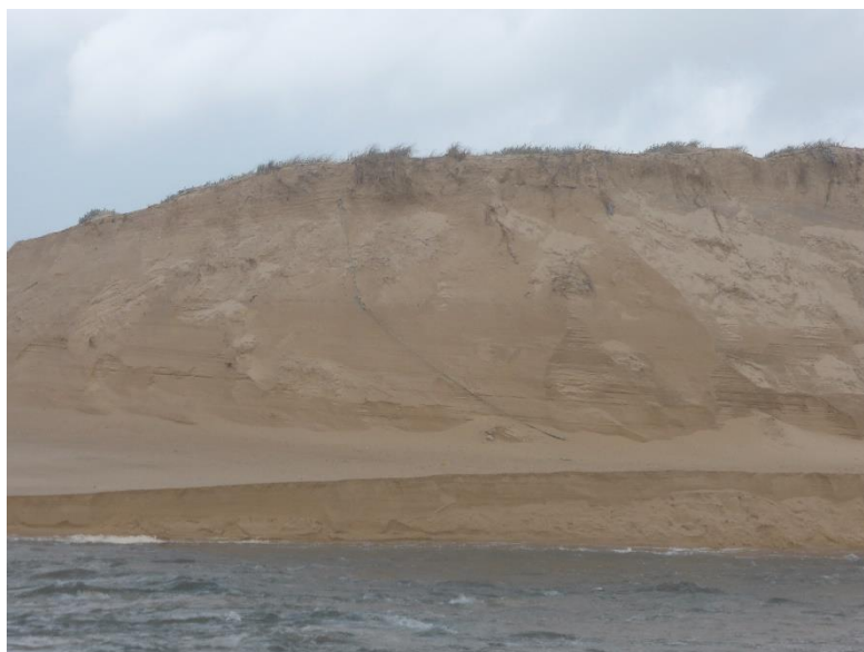
Fotografia 2 – Erosão da Duna artificial pela ação da barra de maré.
